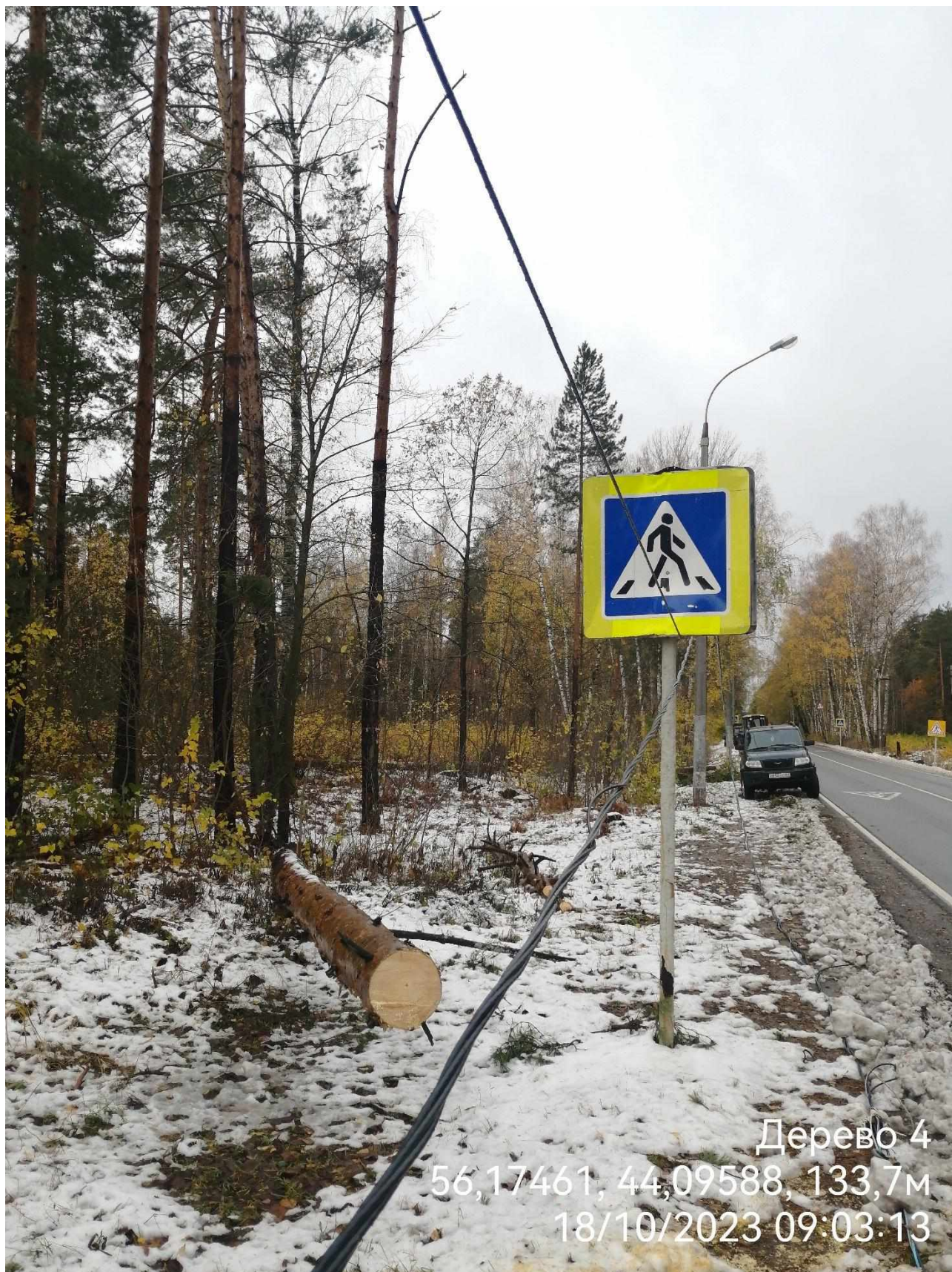
Дерево 4 – упало на дорогу и провода, с дорожного полотна часть дерева убрана незамедлительно
