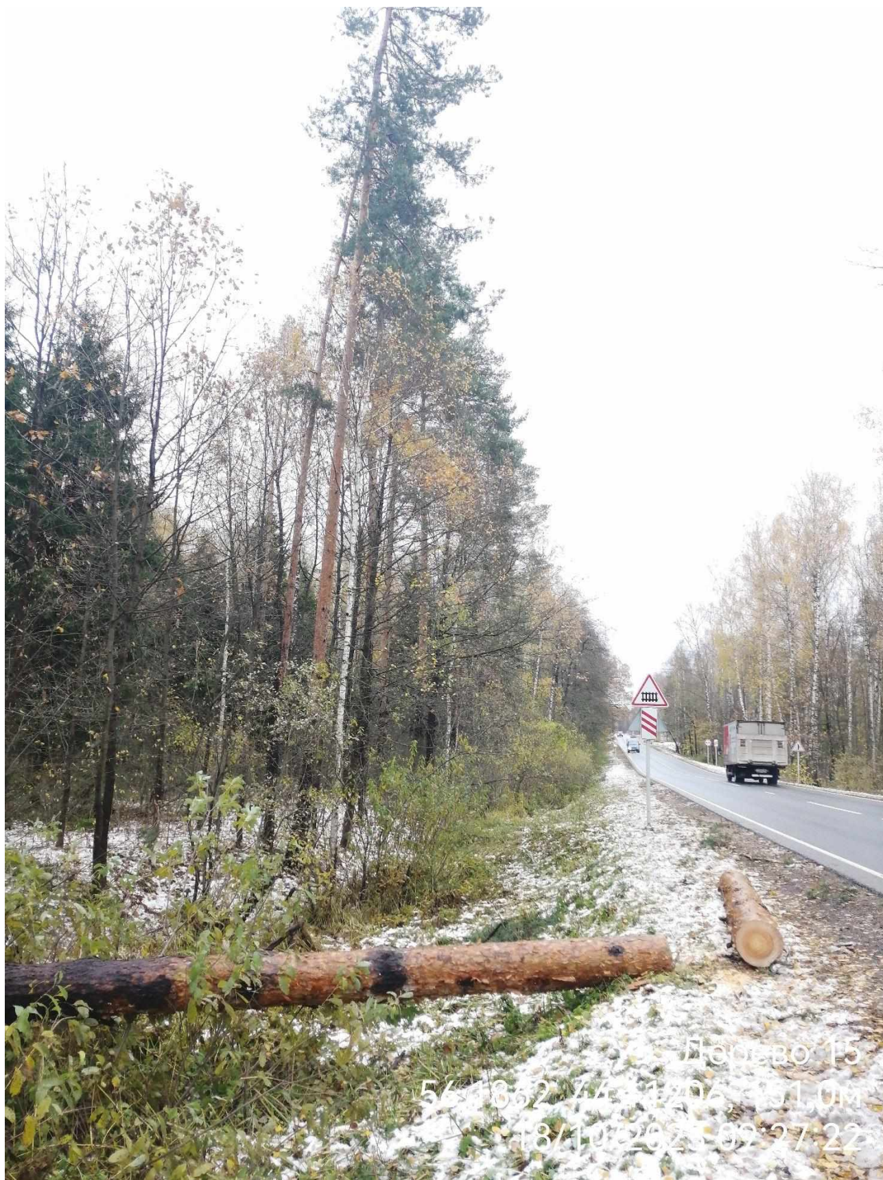
Дерево 15 – упало на дорогу, с дорожного полотна часть дерева убрана незамедлительно
