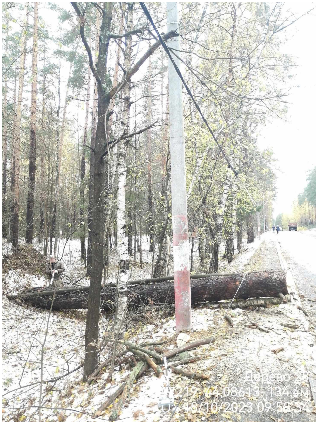
Дерево 28 – упало на дорогу и провода, с дорожного полотна часть дерева убрана незамедлительно
