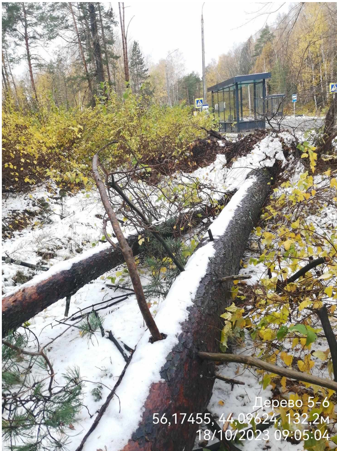
Дерево 5 и 6 – упали вдоль дороги возле остановки общественного транспорта
